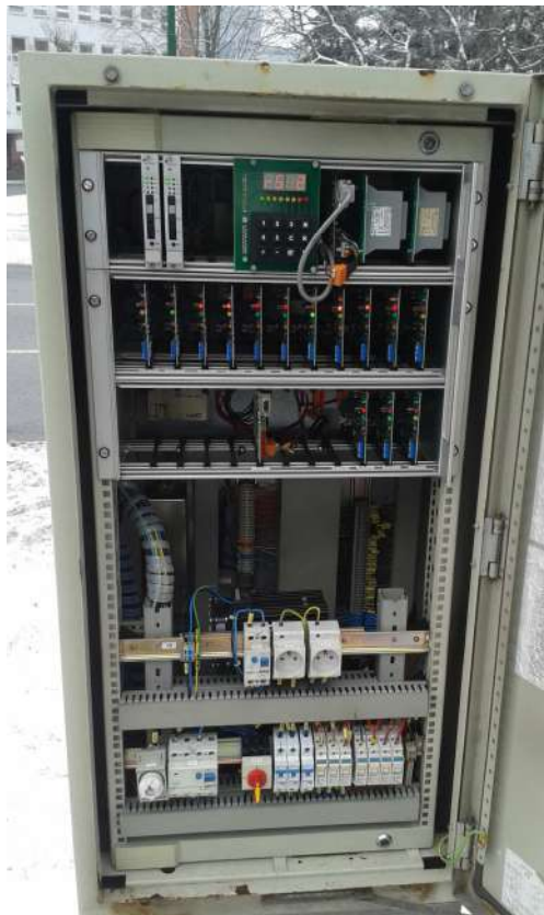
Obr. 2 Pohled do stávajícího řadiče
